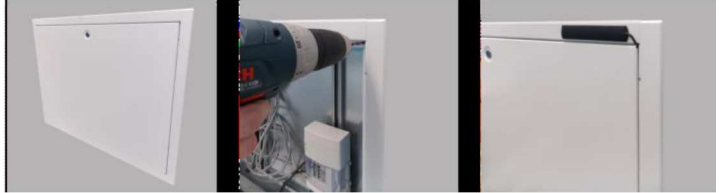
Figure 10 : Exemple pour la fixation de l'antenne externe
