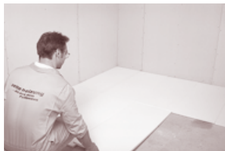
Pose de la première couche d'isolant de sol
